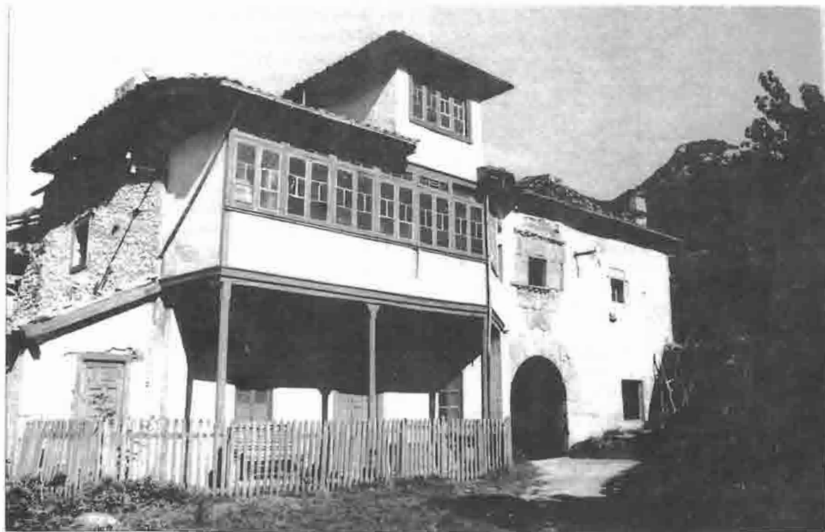
Lám. 60.—Casona de El Patio, El Pino. Vista de la fachada principal.
