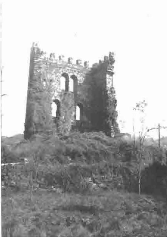
Lám. 53.—Torreón de los Bernaldo de Quirós en Soto.
